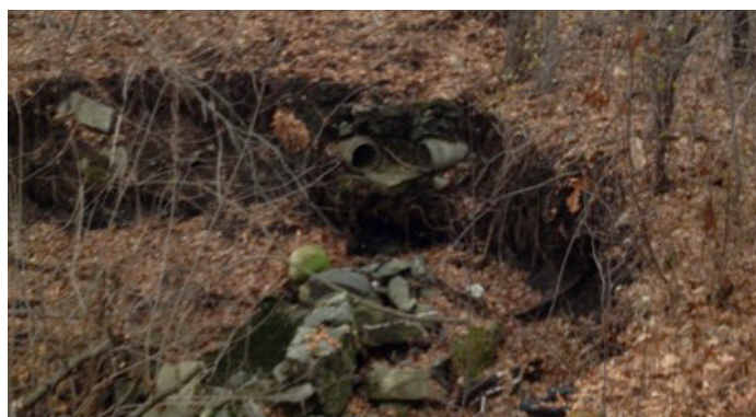
Imagem dos canos de drenagem antiga de 2014.
